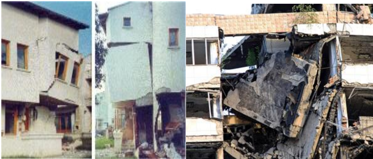
شکل ۱- خرابی های حاصل از تخریب تیر طره در اثر زلزله
