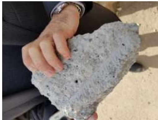
شکل ۱۳- عدم تراکم مناسب بتن در ساختمان بتنی نیمه‌کاره فرو ریخته در اسلام آباد (الف)
