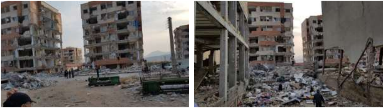
شکل ۱۰- تخریب گسترده در عناصر غیر سازه‌ای در ساختمان‌های اسکلت بتنی در مجموعه مسکن مهر شهید شیرودی در اسلام‌آباد غرب
